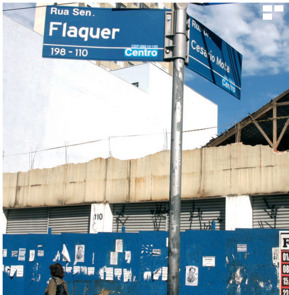
Teatro Carlos Gomes: tapumes escondem obras duvidosas
